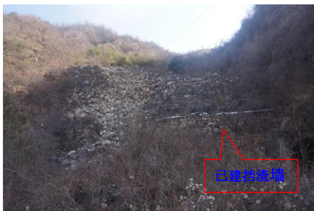
照片 2-9 1#废石场已建挡渣墙
