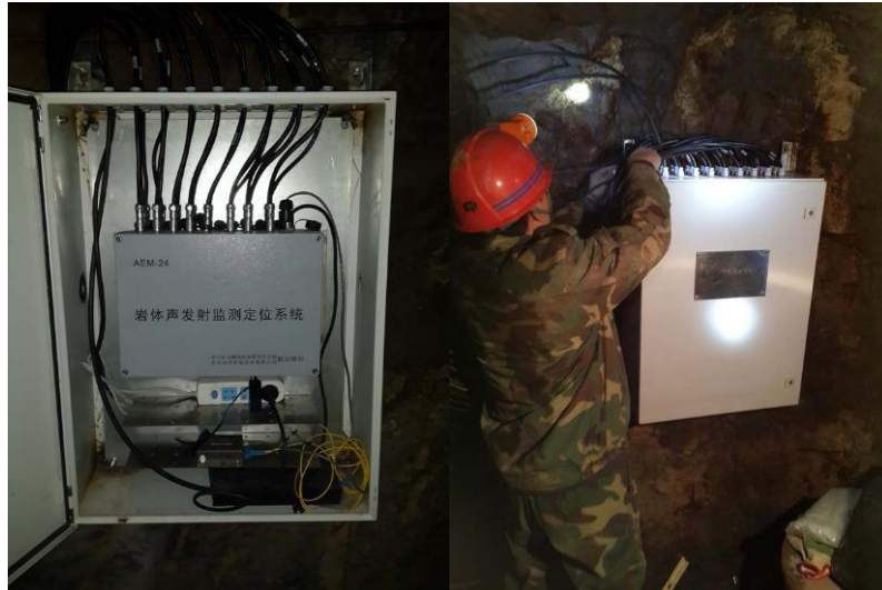
图 5-12 AEM 机柜及安装图
