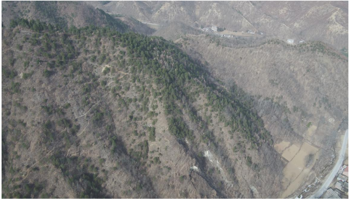
项目区航拍照片
