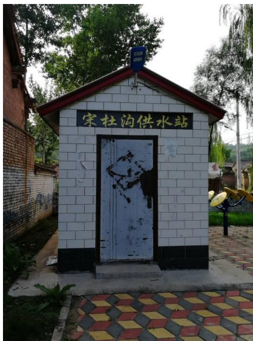
照片 3-2-29 宋杜沟村供水站
