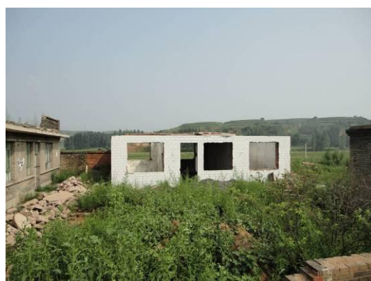
照片 3-2-14 搬迁后未拆除的房屋
