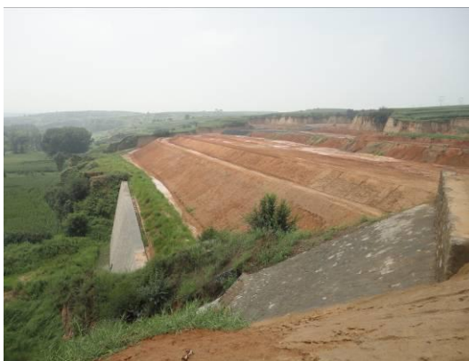
照片 3-2-26 西寨沟矸石场拦渣坝
