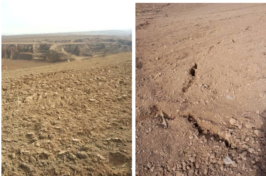
照片 3-3-10 局部沉陷已复垦区域出现新裂缝（矿方提供）
