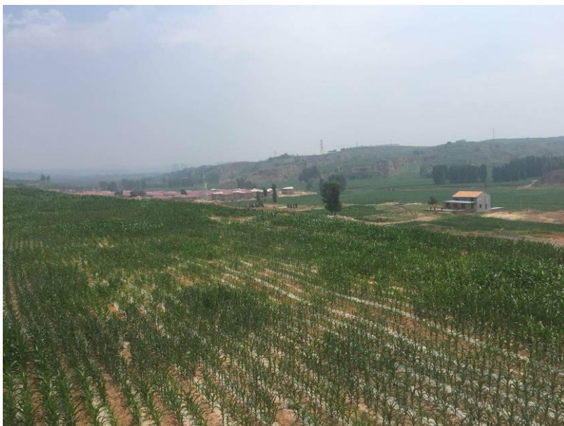
照片 2-6-6 地面塌陷治理（矿区北部）
