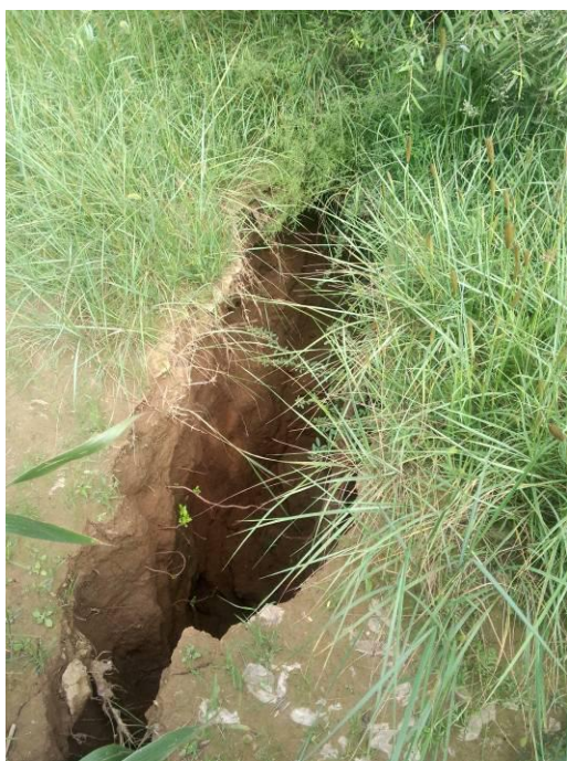
照片 3-2-1 地裂缝（现场调查）
