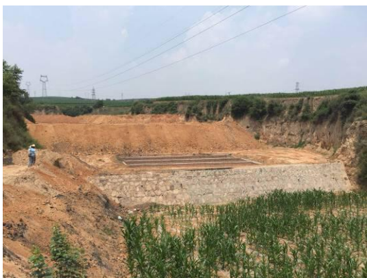
照片 3-2-25 南燕竹矸石场拦渣坝
