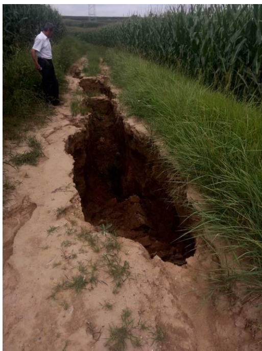
照片 3-2-5 地面塌陷坑（现场调查）
