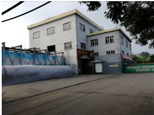
照片 3-2-20 工业场地主斜井
