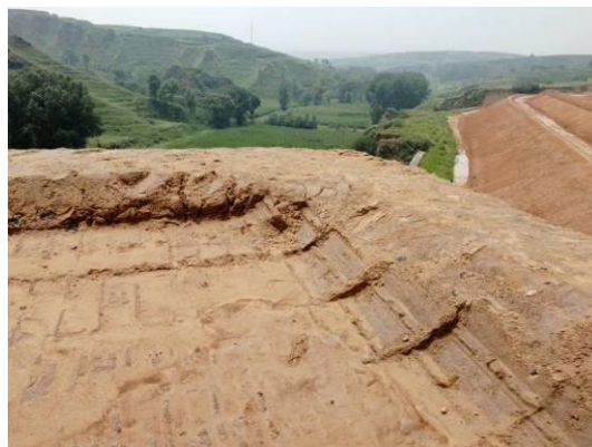
照片 2-6-9 西寨沟矸石场平台围堰
