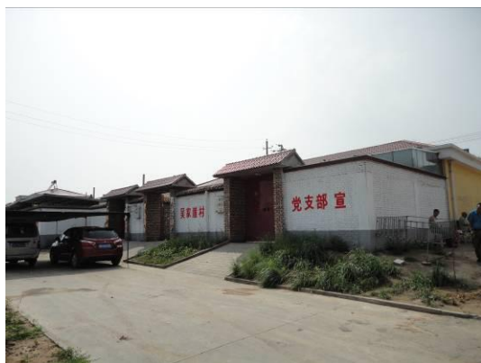
照片 3-2-15 搬迁村庄安置点 (3) 崩塌、滑坡
