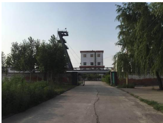
照片 2-1-4 冀家塆风井场地地形地貌
