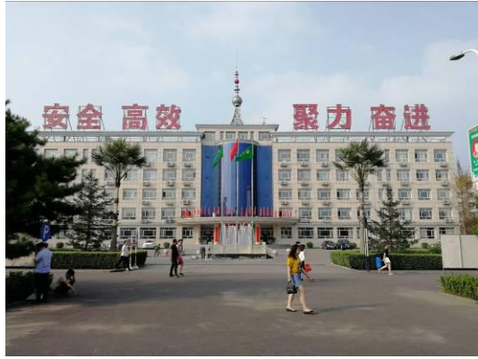
照片 3-2-18 工业场地办公楼
