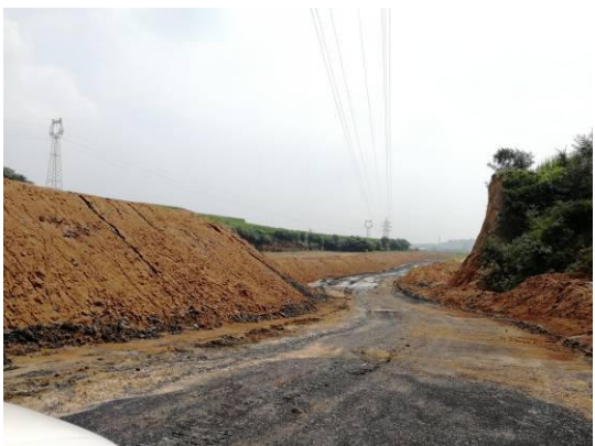
照片 3-3-5 正在层间覆土
