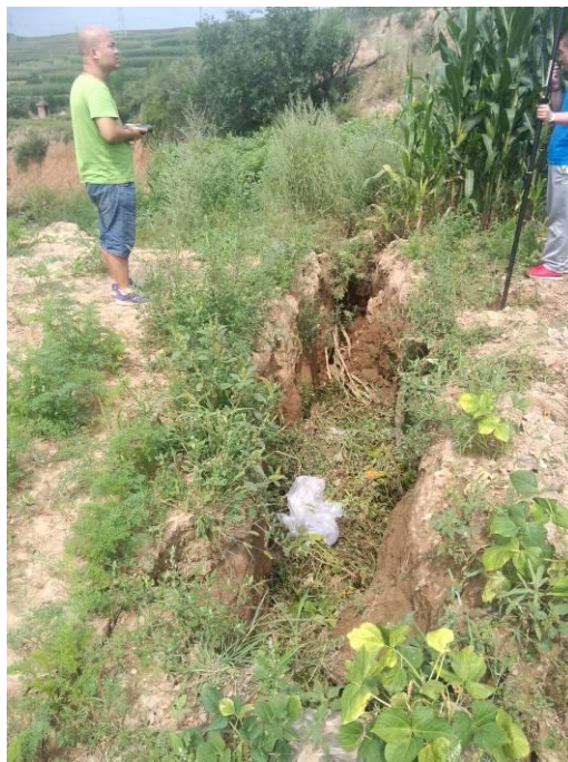
照片 3-2-4 地裂缝（现场调查）
