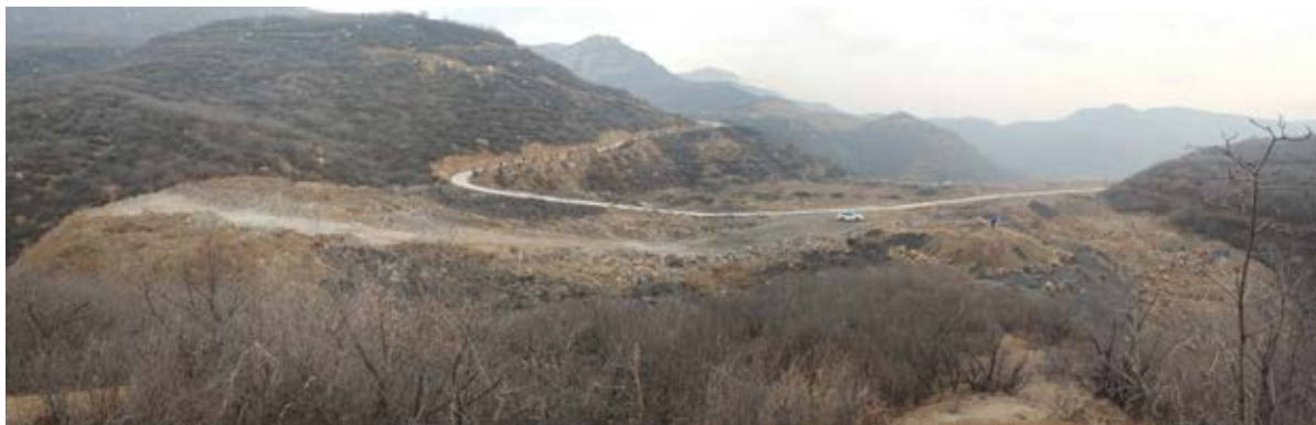
a) 老西掌沟头堆渣点全貌
