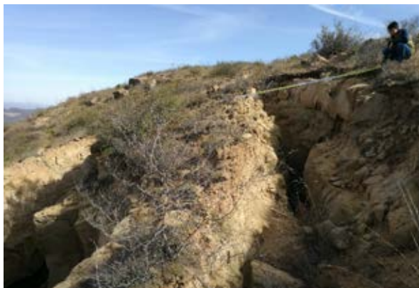
c) 中部连续裂缝
