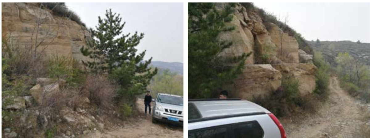
图3-25 B11 崩塌点现状
