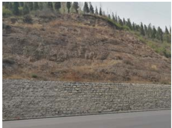
d) 307 国道挡墙+主动防护网
