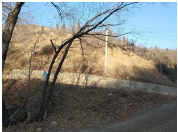
d) 崩塌区 D 段
