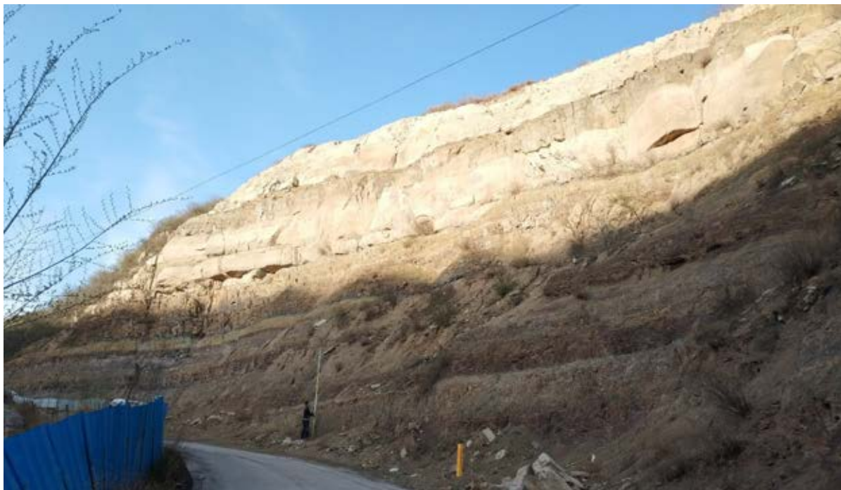
图3-22 B8 崩塌点现状
