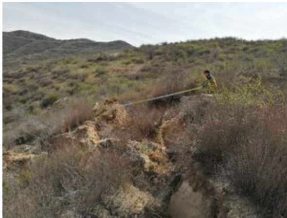
e) 重度塌陷地裂缝破坏土地
