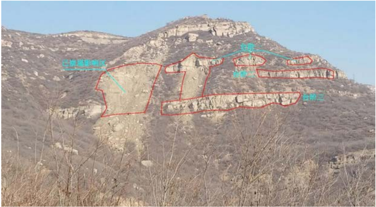
图3-14 B3 崩塌总体现状
