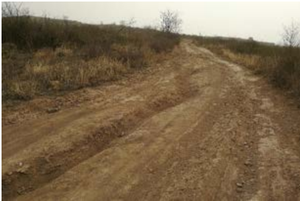
c) 中部分水岭地裂缝
