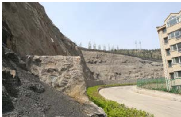
图2-38 秋沟三期住宅楼南侧锚喷护坡
