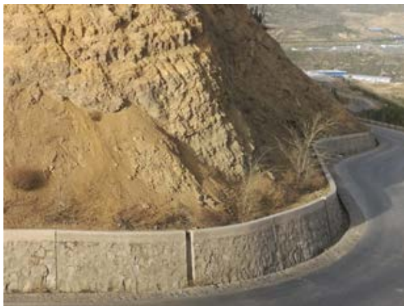
c) 一矿排矸路挡墙
