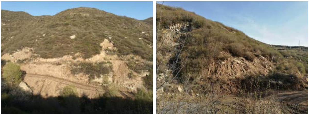
图3-26 H1 滑坡现状
