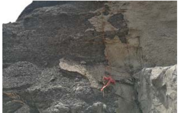
图2-38 秋沟三期住宅楼南侧锚喷护坡
