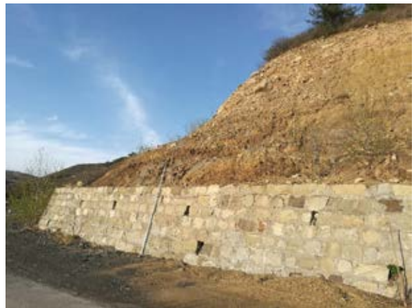
d) 中段挡墙现状
