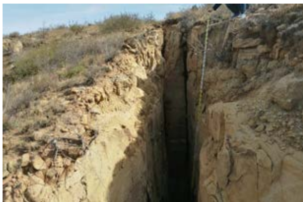
e) 中部超深裂缝
