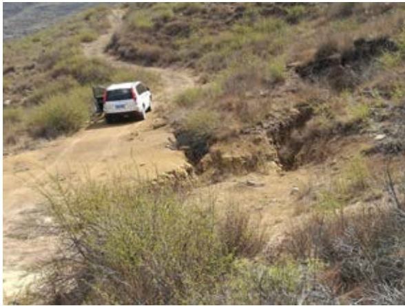
a) 松帽梁独立山脊地裂缝
