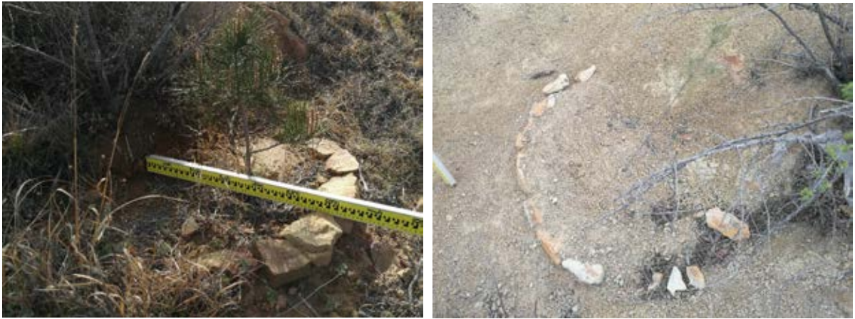
图5-8 鱼鳞坑植树现场情况
