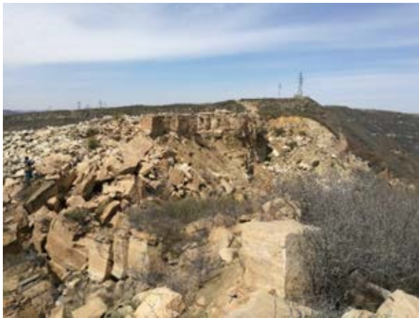
c) 深大裂缝（镜向西北）
