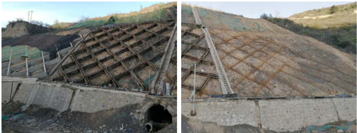
图2-39 菱形格构护坡施工现场
