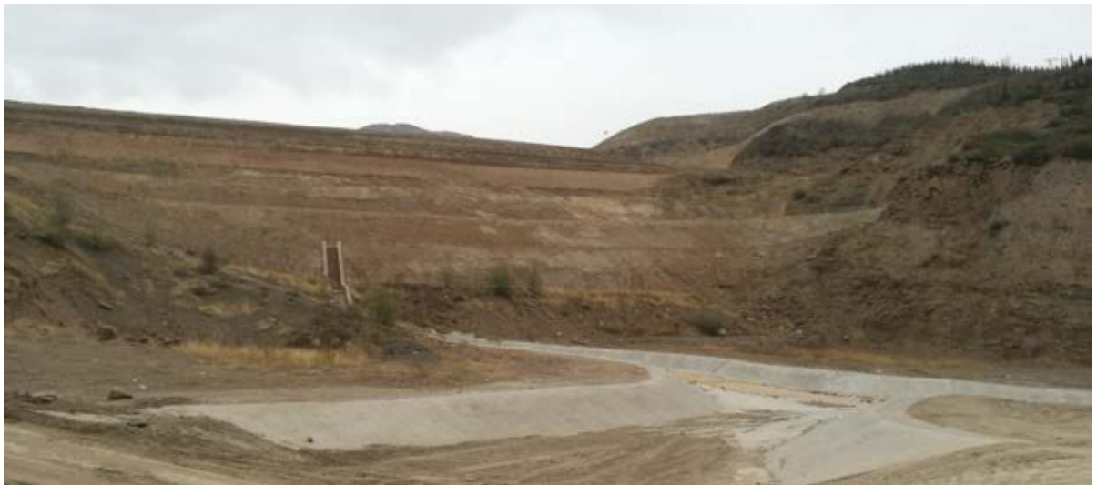
图1-16 在用矸石山台阶坡面及底部排水沟
