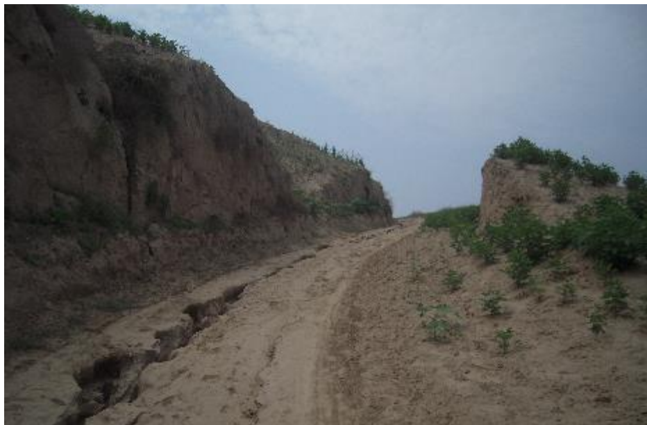
照片 2-15 道路雨水冲刷淘刷形成的损毁
