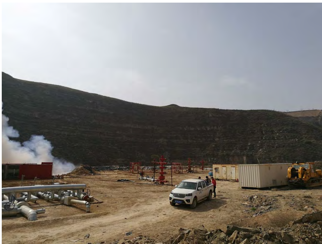
图 1-16 井场现场照片
