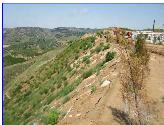
图 3-8 BW08 潜在不稳定斜坡
