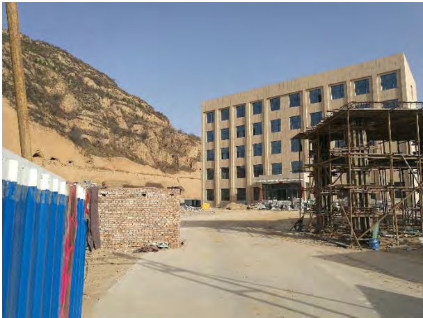
图 3-13 已建生产调度中心
