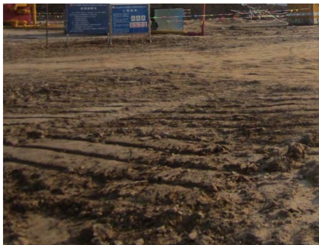
图 2-27 大吉 5-6 井区大吉平 02 井场翻耕照片
