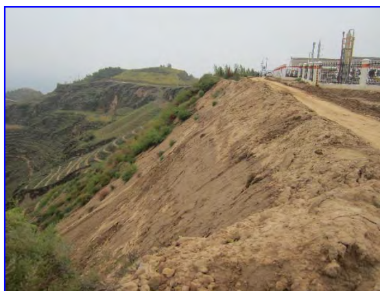
图 3-10 BW09 潜在不稳定斜坡
