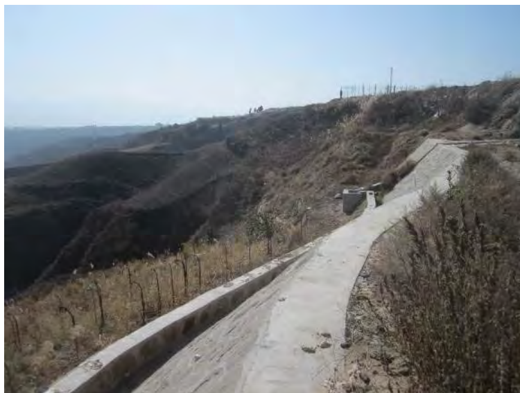
图 2-24 大吉 5-6 井区挡土墙
