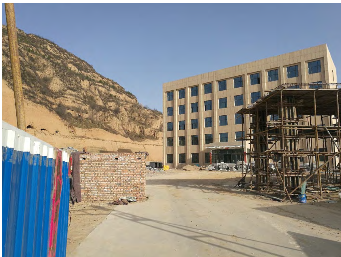
图 1-15 生产调度中心处理站
