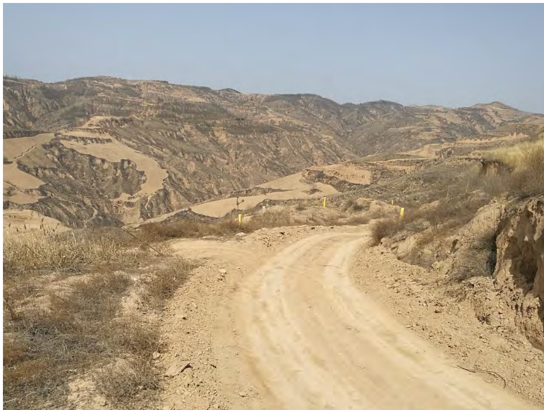
图 1-18 进场道路现场照片
