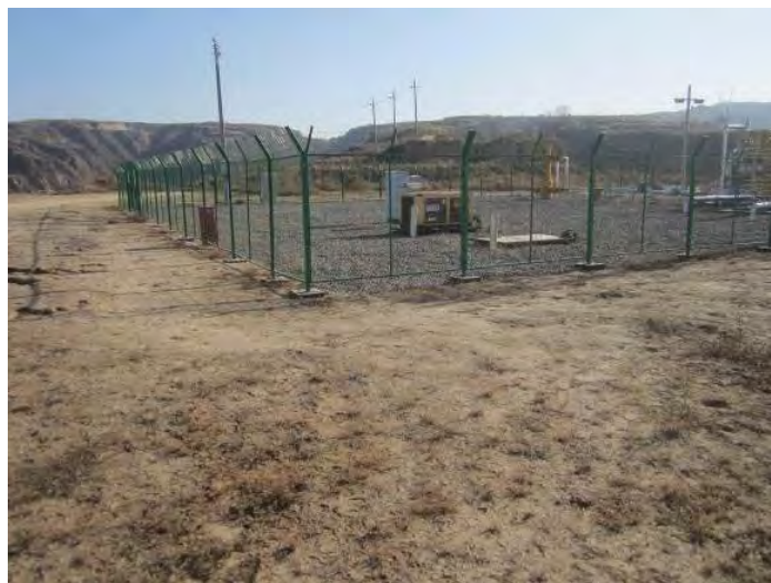
图 2-26 大吉 5-6 井区大吉 11 井场铺砂砾、碎石
