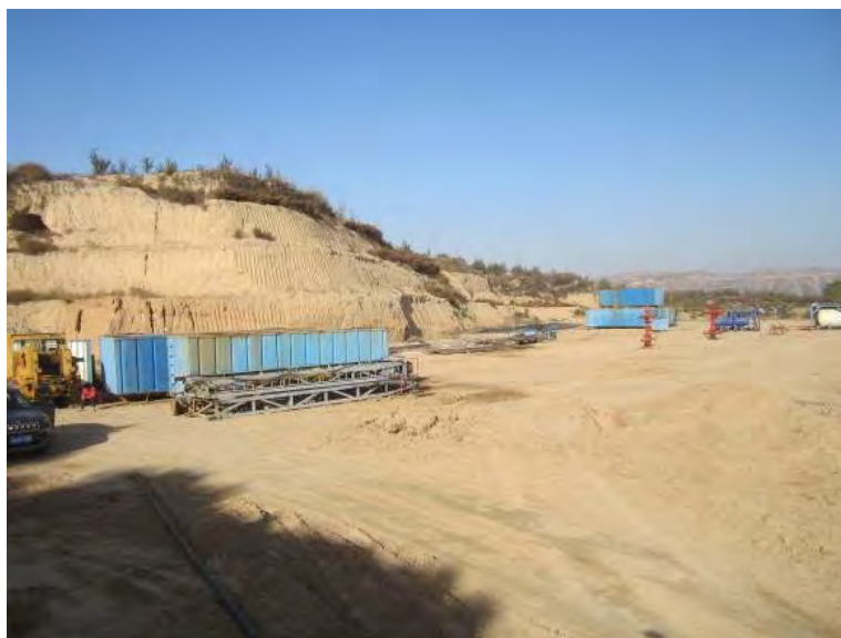
图 2-23 大吉 5-6 井区吉 7-6A 井场削坡图
