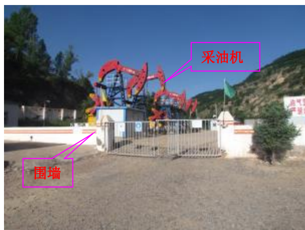
照片 1.3-2 丛井(金坪 102 井场) 镜向 NE
