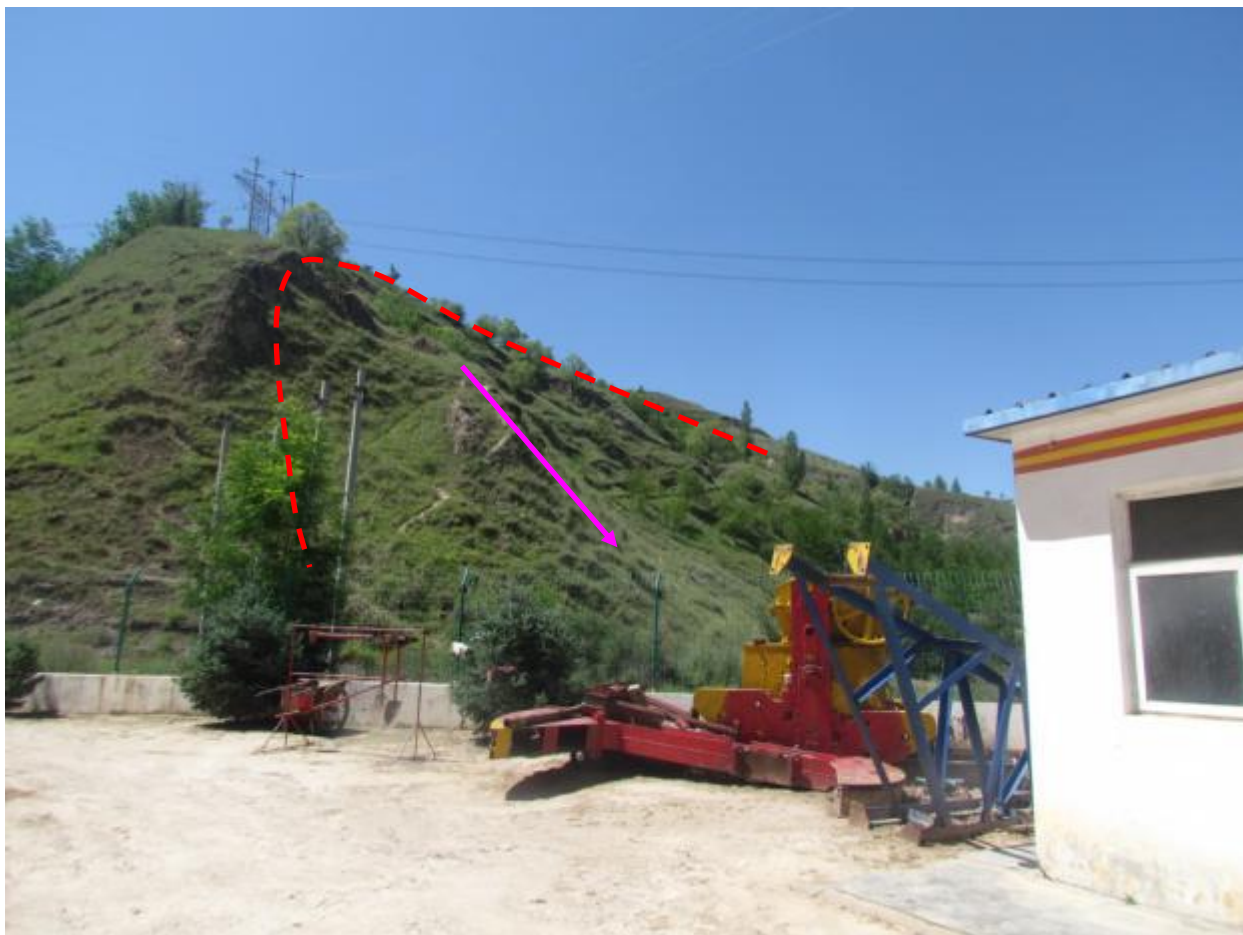
照片 3-2.3 滑坡 H 3 局部地貌（镜向 N）
