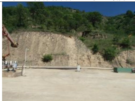
照片 2.6-3 削坡治理(金坪 27, 镜向 N)
