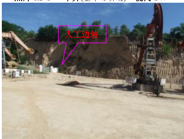
照片 1.3-3 井场边坡(金坪 39 井场) 镜向 N
