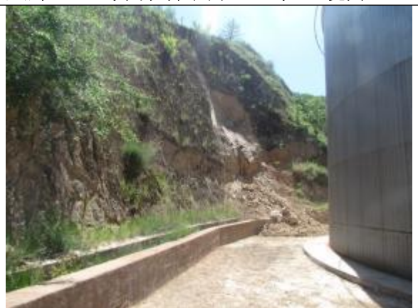
照片 2.6-4 截排水渠(马子川脱水站, 镜向SE)
