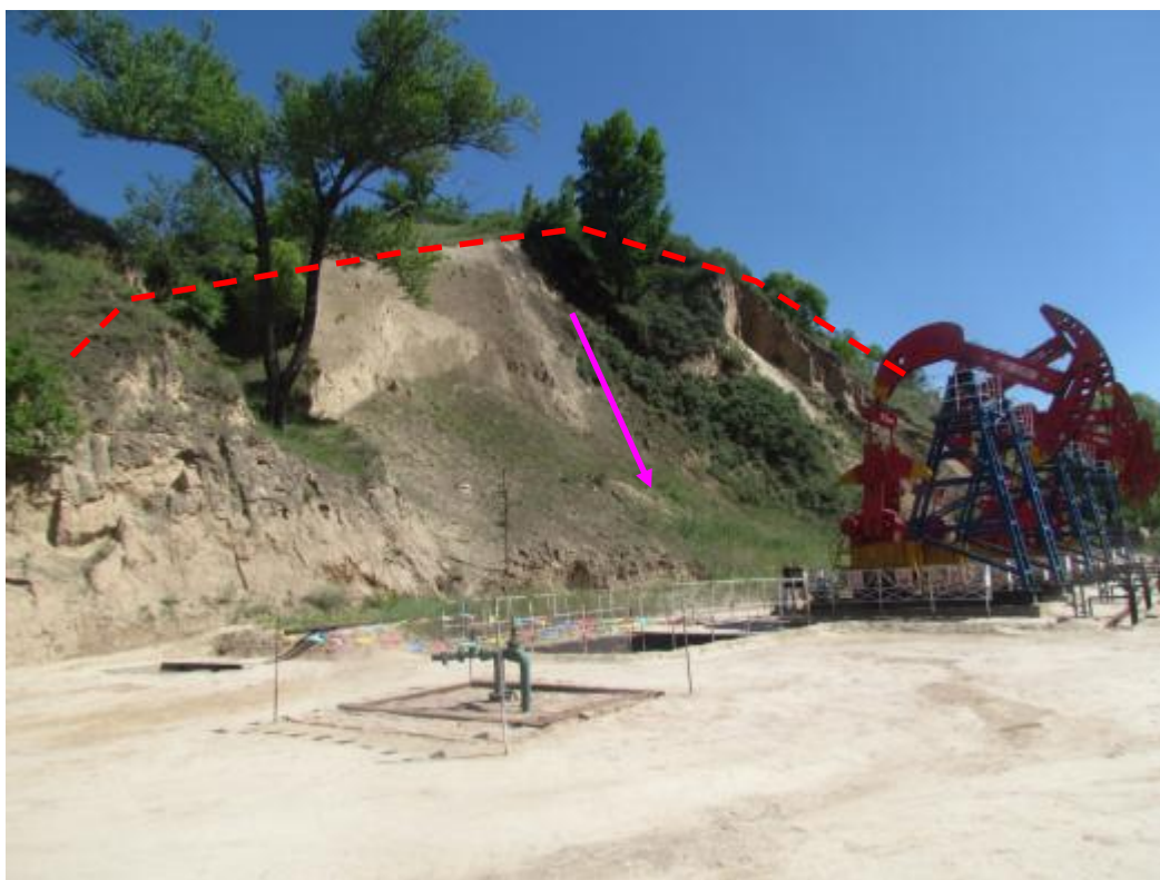
照片 3.2-5 B 11 崩塌（隐患）侧面地貌（镜向 SW）
