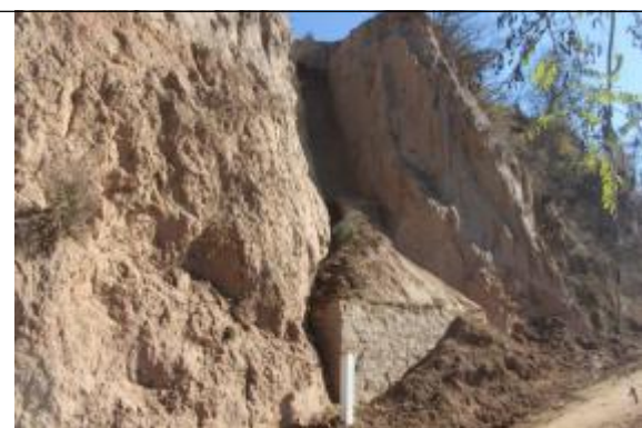
照片 3.2-9 注水管线穿越高陡边坡
