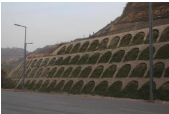
照片 2.6-7 附近公路边坡治理效果
