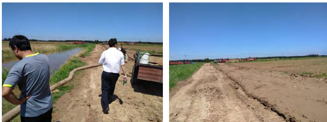
照片 2-13 菜园村北侧东八采区塌陷区治理现场
