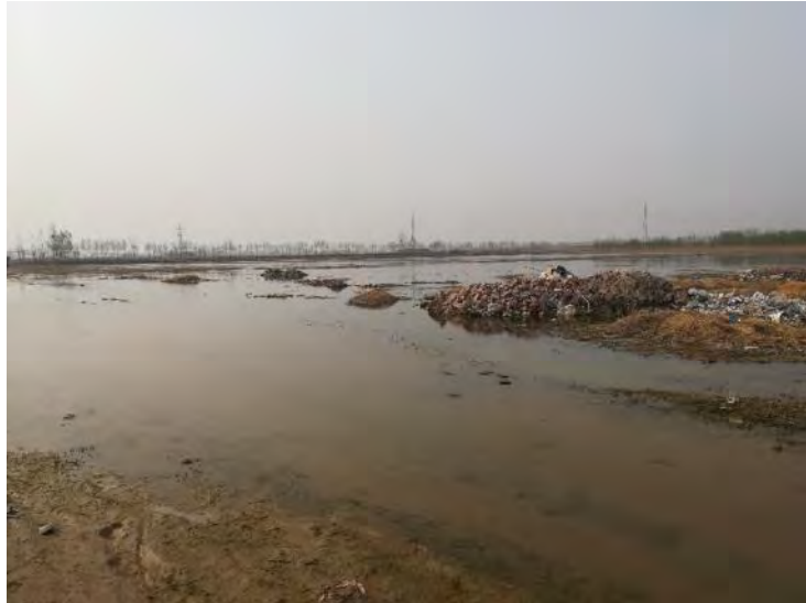
照片 3-15 司家村西北地面塌陷（农灌期积水，二采区）
