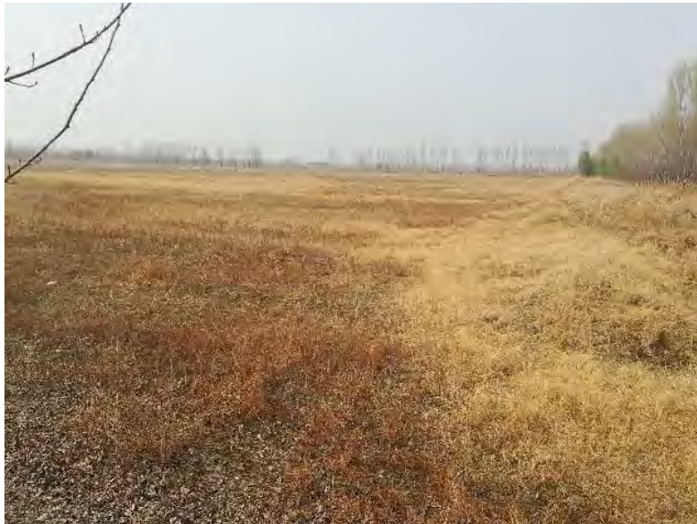
照片 3-10 司家村东南地面塌陷（二采区）
