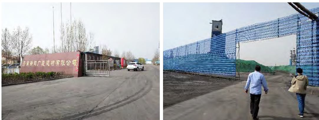
照片 1-1 矸石制砖厂现状 1
