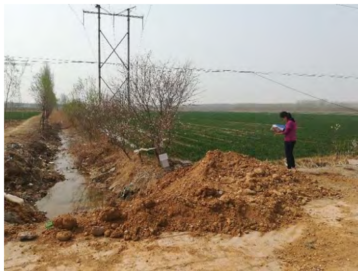
照片 2-6 排水斗沟
