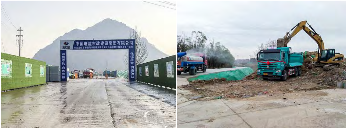
照片 4-1 济南华山湖项目施工现场
