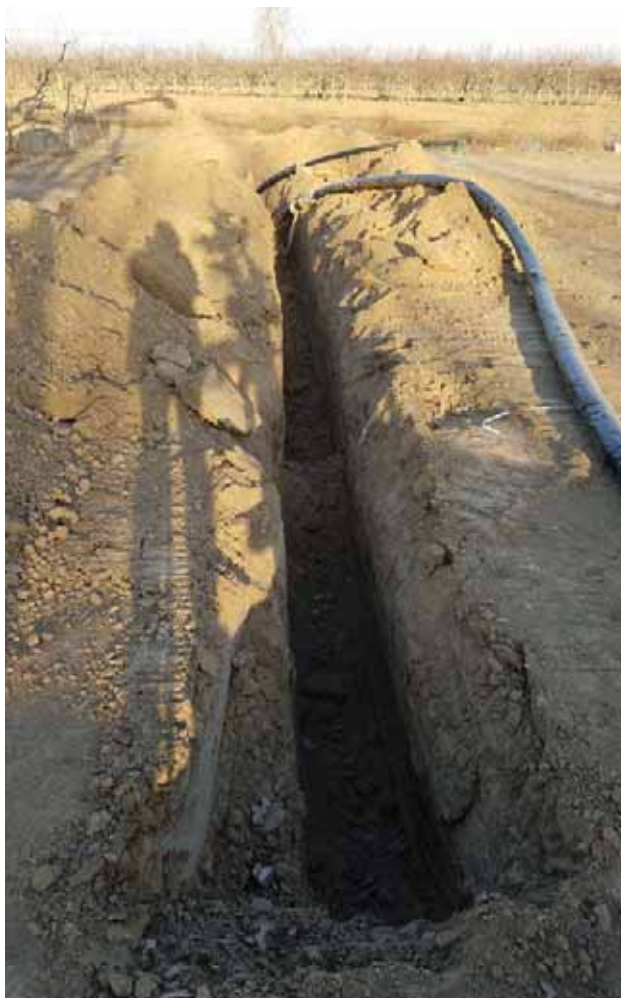
照片 1-11 敷设中的输油管线
