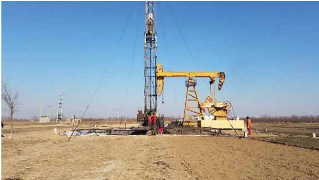
照片 3-4 在建井场（镜向东）
