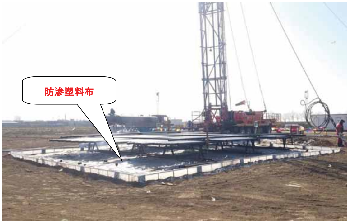
照片 4-1 钻井期防渗塑料布铺设
