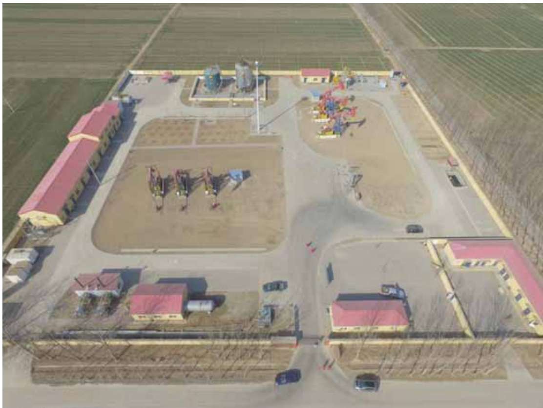
照片 1-4 束 6 拉油注水站
