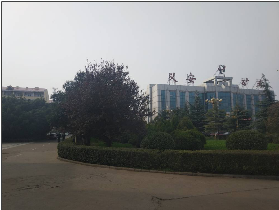
图 1-2 正村煤矿综合办公楼
