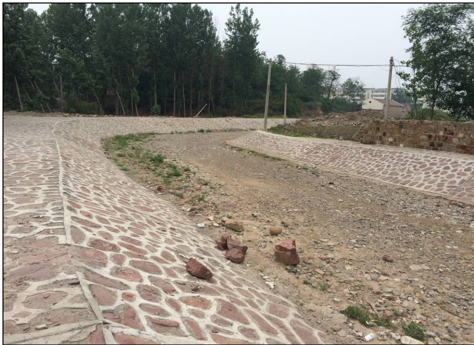
图 4-3 范沟水库渠道现状
