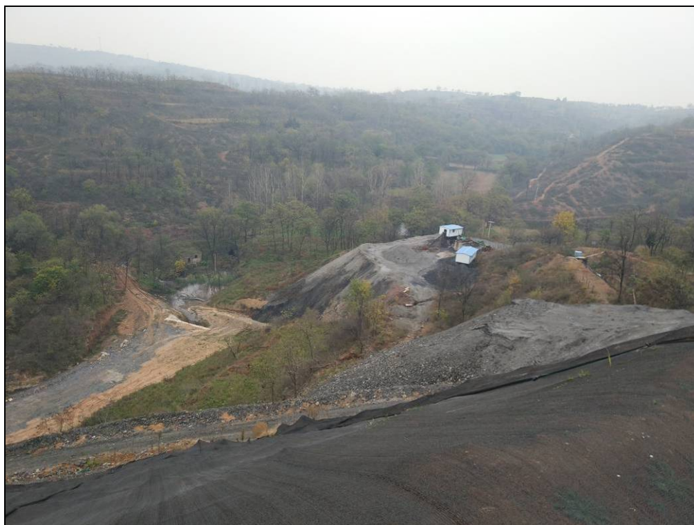
图 1-10 正村煤矿矸石堆场现状
