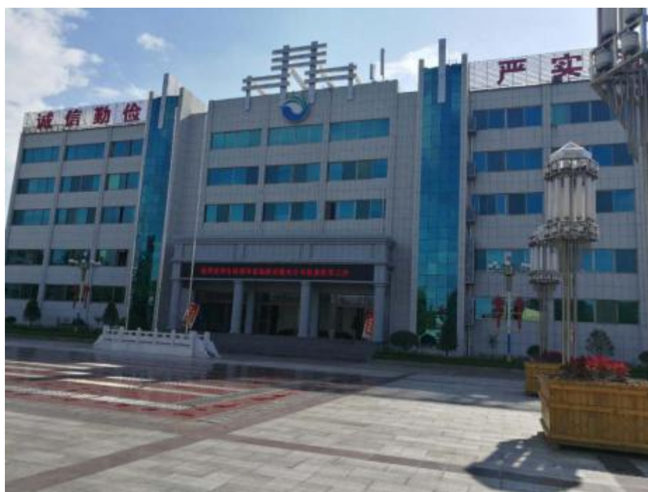
图 3-69 新安煤矿二号井工业广场办公楼
