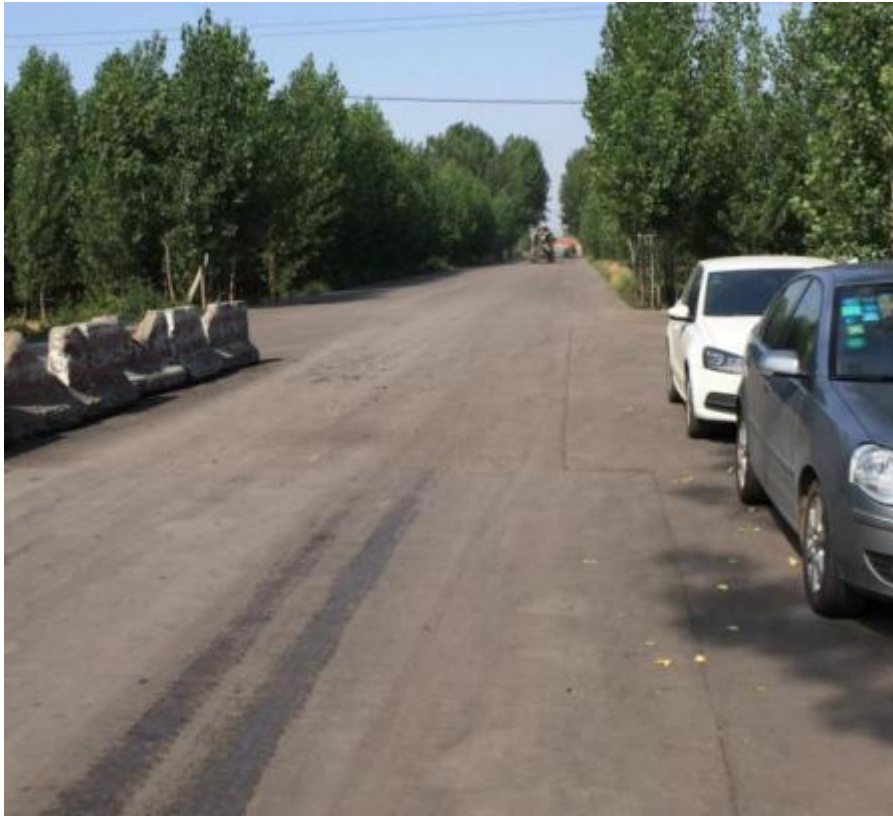
图 3-75 二号井运输道路现状
