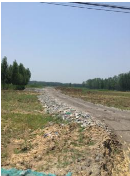
图 0-2 峦谷堆村塌陷地治理现场
