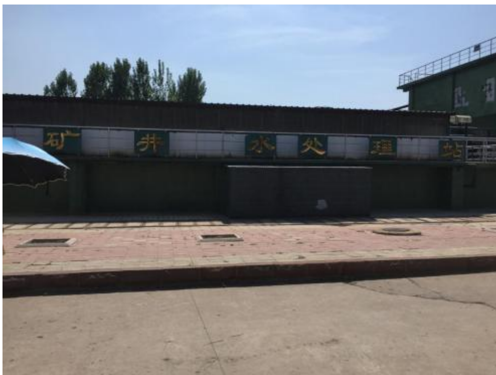
图 3-43 一号井矿井水处理站
