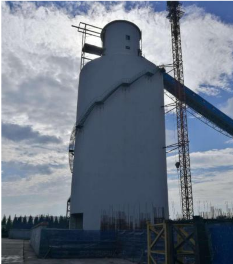
图 3-73 新安煤矿二号井煤仓
