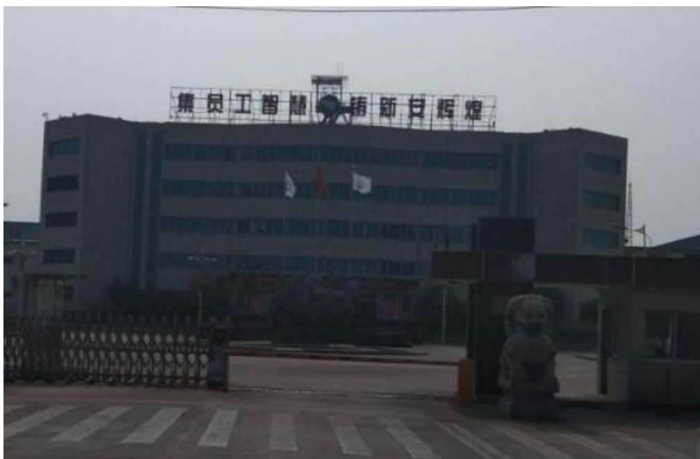
图 3-62 新安煤矿一号井工业广场办公区
