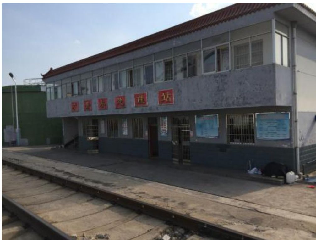
图 3-45 二号井矿井水处理站
