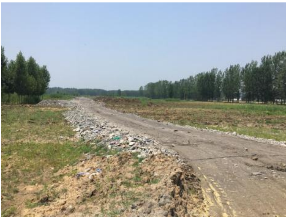
图 3-76 峦谷堆村治理现场
