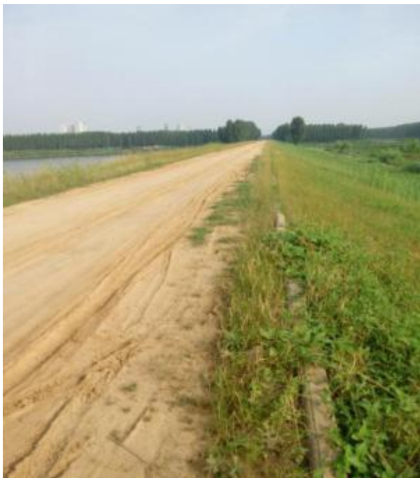
图 0-1 整治的堤坝（由北向南）
