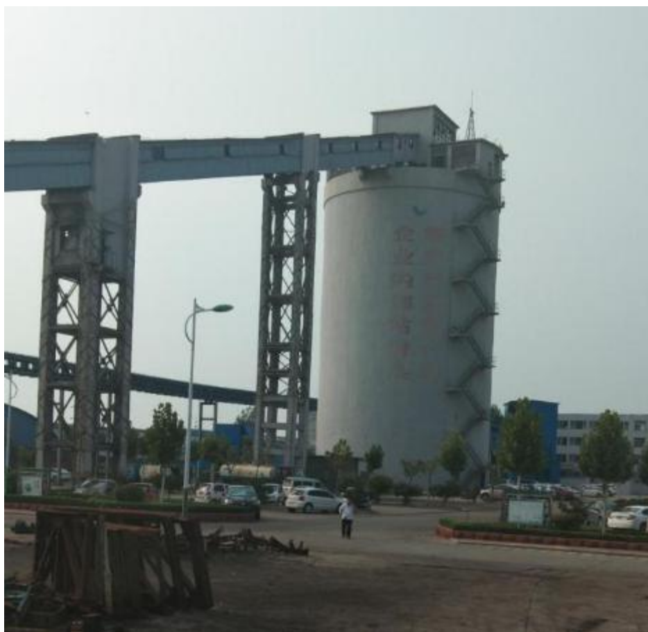
图 3-66 新安煤矿一号井工业广场储煤区
