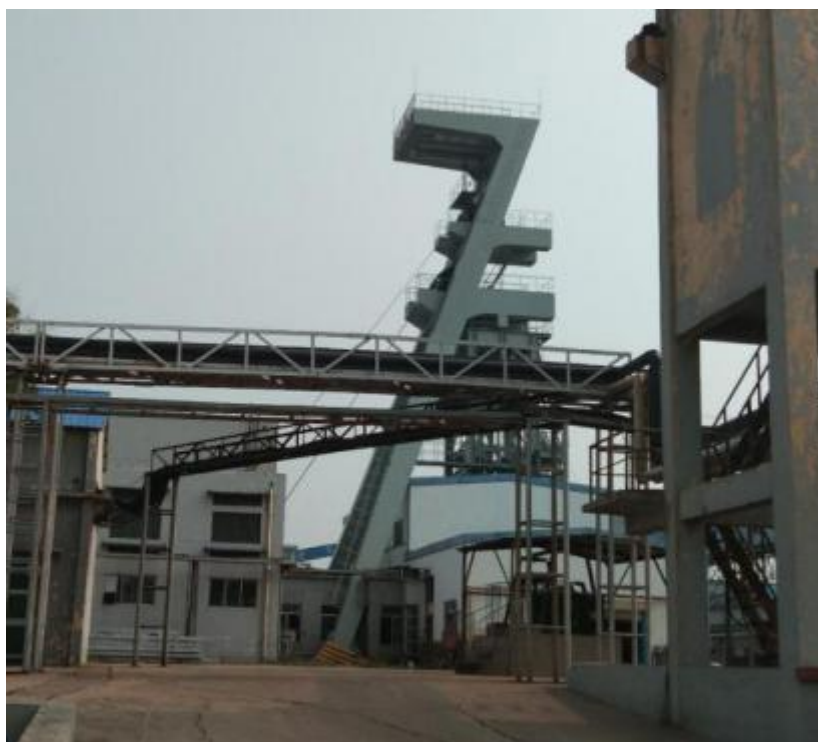
图 3-64 新安煤矿一号井工业广场主井
