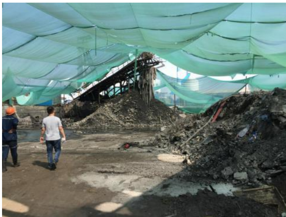
图 3-67 新安煤矿一号井工业广场临时矸石堆场
