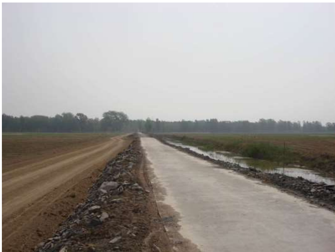
照片 2-18 复垦道路照片
