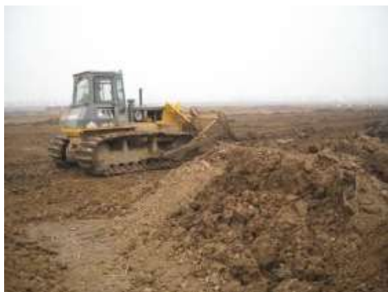
照片 2-23 复垦现场照片
