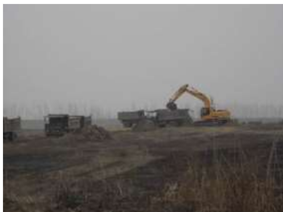
照片 2-24 复垦现场照片
