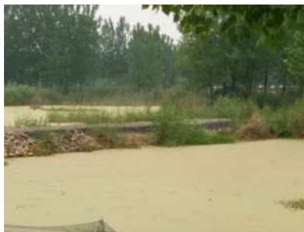
照片 3-6 塌陷积水区
