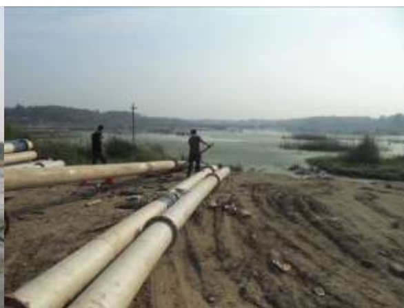
照片 2-28 复垦现场照片
