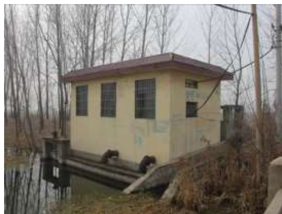
照片 2-22 复垦后配套的排灌站
