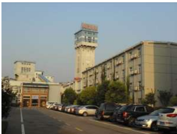
照片 3-1 主副井工业广场
