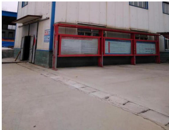
图 1-16 主提升井附近的排水沟
