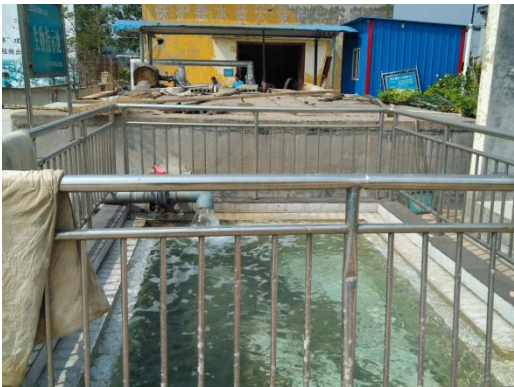
3-2 现场调查矿区污水处理厂
