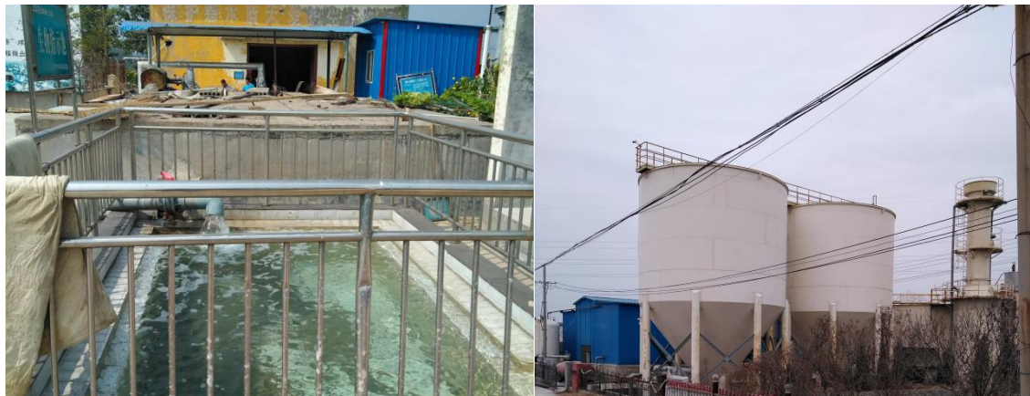
图 1-4 污水处理厂现场照片
