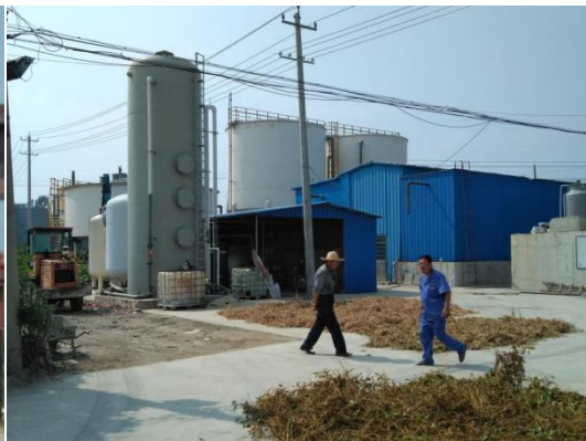
图 3-9 污水处理厂压占土地
