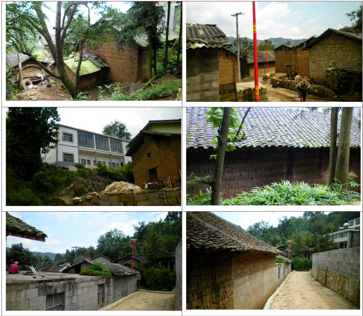
照片 3.2-1 老衲拖村民房现状
