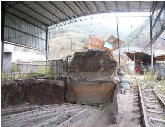
照片 1.5-4 副斜井（保留）
