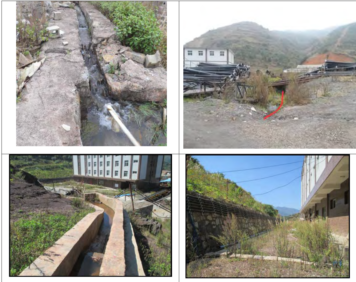
照片 2.1-1 矿区内排水沟
