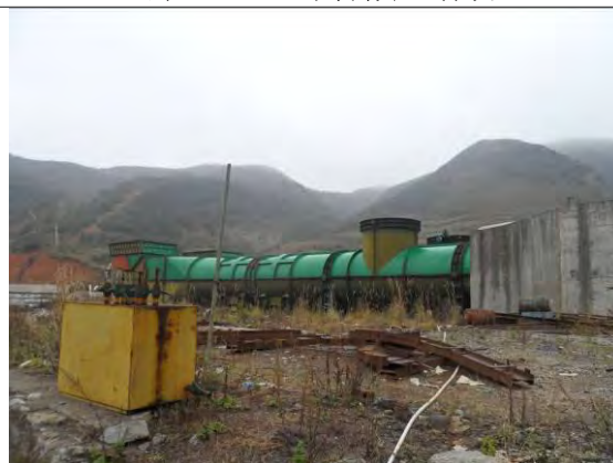
照片 1.5-6 风机平台（保留）
